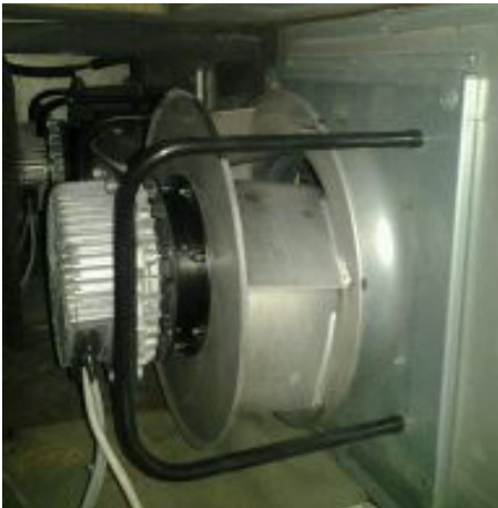
Uudet puhaltimet asennettuna
